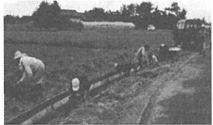
生態系に配慮して施工された水路を管理する住民（宮城県：山元且理）
