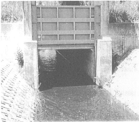
写真1 百間川への放流水門（端'97.6）
