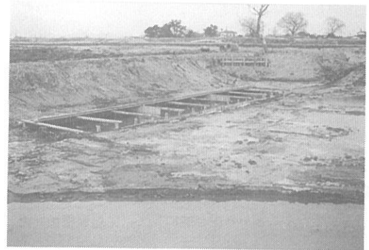
写真9 地区内に整備した“ぬくめ”
