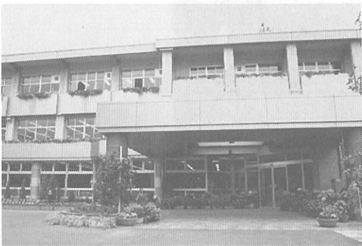
1階、そして2階3階にも花が飾られる役場庁舎
