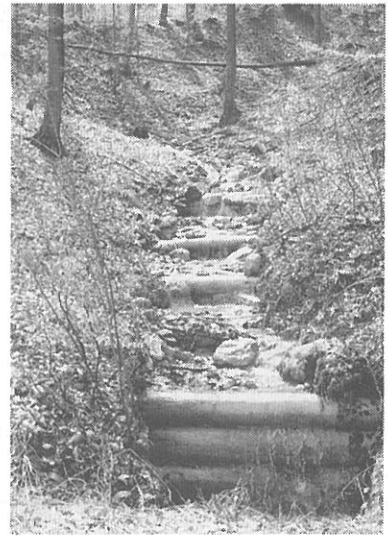
写真-7 間伐材を材料にした土木構造物は生物界にも物質界にもエコロジカルである
