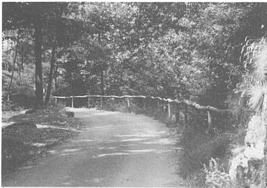
写真-2 森の中の歩道のフェンスには、現地発生丸太材をできるだけ皮つきのまま使用する
