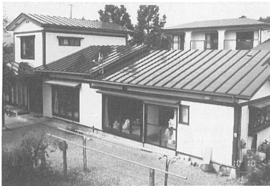
写真-6 屋根の塗り替え後
