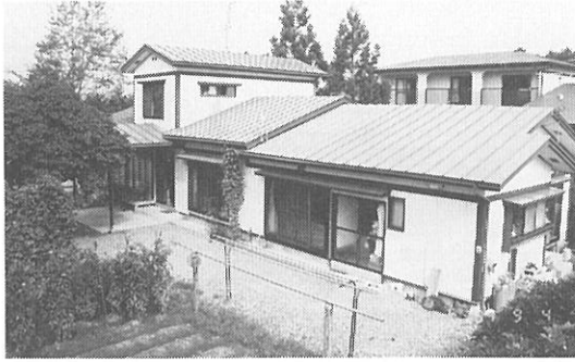
写真-5 屋根の塗り替え前
