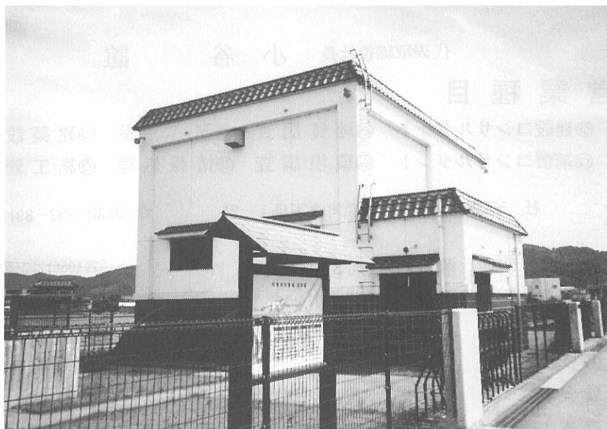
岡山県倉敷地方振興局納 湛水防除事業 粒浦排水機場
