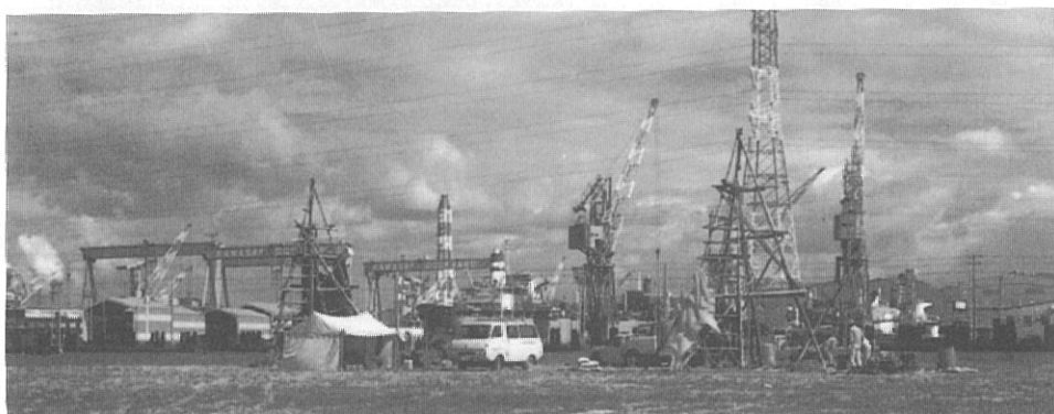
調査ホーリング
