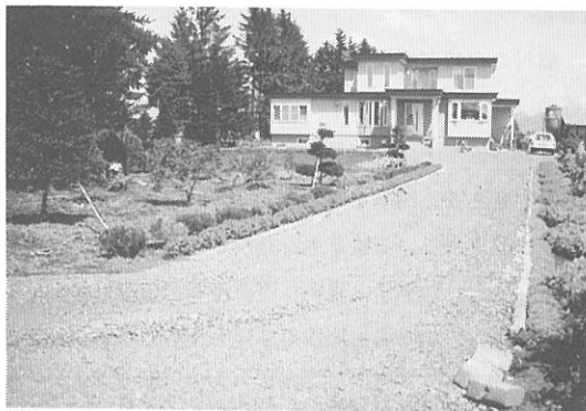
写真-4 新設した生活道路(沿道の修景)
