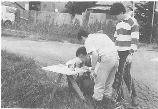
写真一 現況図作成のための測量
