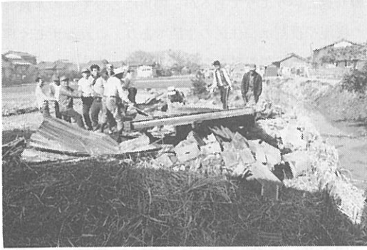
写真-7 住民による不法占拠物の撤去
