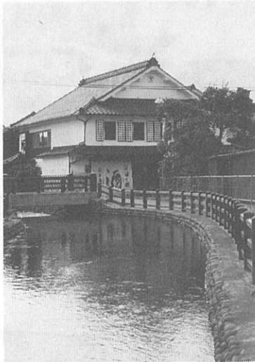
写真-1 農業水利施設高度利用事業「南新川」
