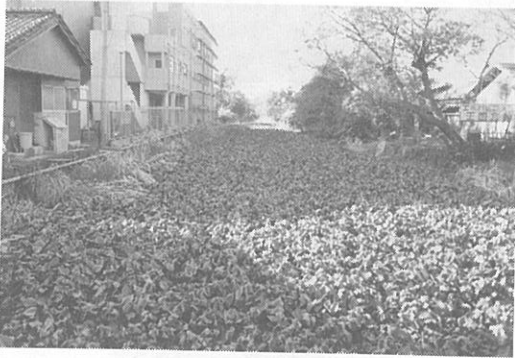
写真-1 水草（ホテイアオイ）とヘドロとゴミで埋没した水路（幹線）（昭和52年頃）
