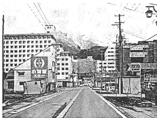
写真-1 湯沢町岩原リゾートマンション群
