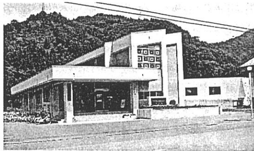
写真-1 農村環境改善センター
