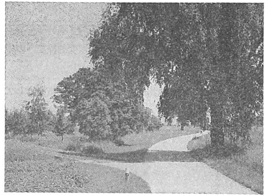
図一4 農地整備の中で造られた農道。路肩に接した木をはじめあちこちの木がほとんど切られずに残されている。われわれのように道路を真直にはせず、舗装も簡易舗装である。
