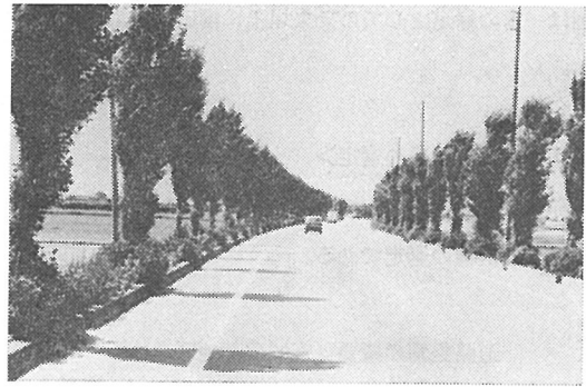
県営ほ場整備事業で幅員5.5mの支幹線を整備したのち、市で15mまで拡幅し植栽した道路
