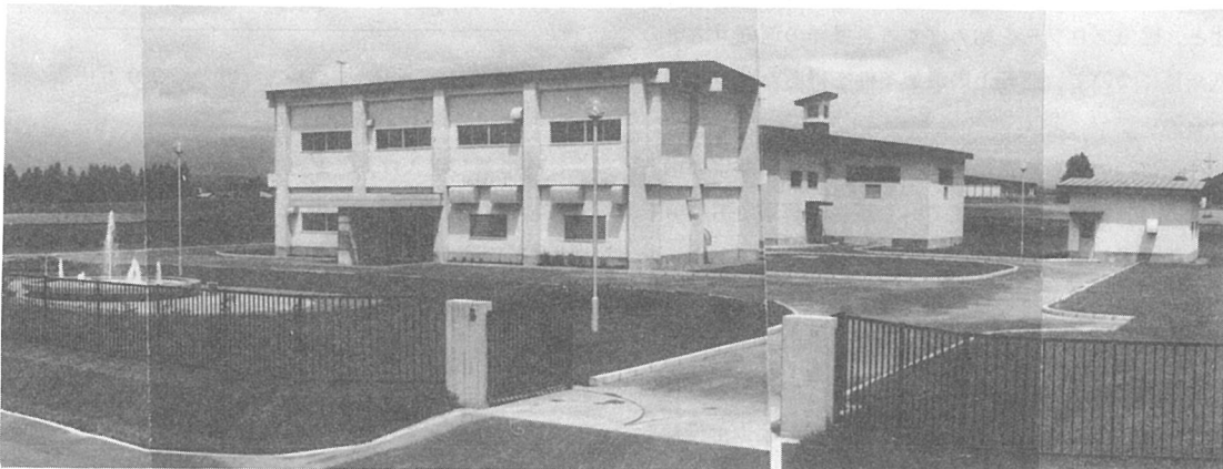
写真-1 終末処理場全景
