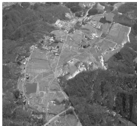
Fig. 4 高宮地区の着手前全景
