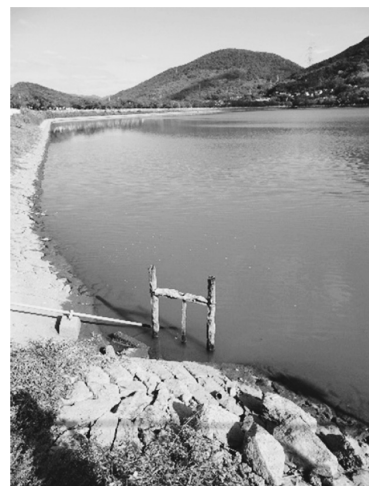
写真-6 鎌田池護岸石・ゆる跡
