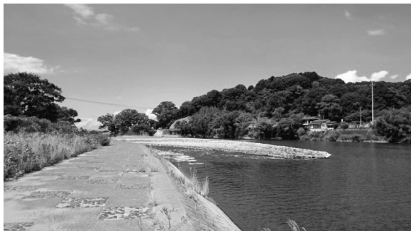
写真-1 上流部から撮影した山田堰（河川に対して斜め方向に設計されており、本流（左岸側）と取水口（右岸側）に分水されるような形になっている）
