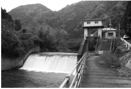
写真-3 中山川取水堰（左岸床板部が幹線水路）
