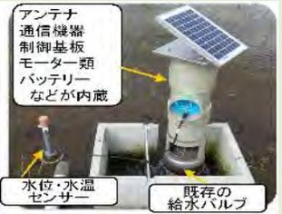
アンテナ 通信機器 制御基板 モーター類 バッテリーなどが内蔵
