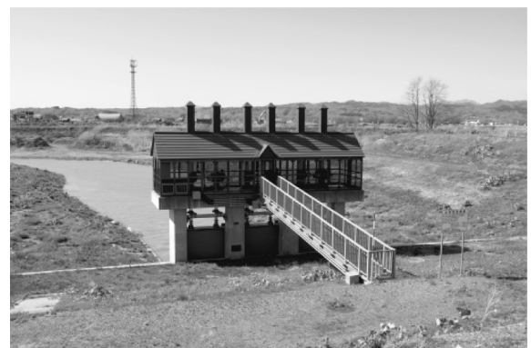
写真-3 篠津運河起点の水門（取水口の背面）
