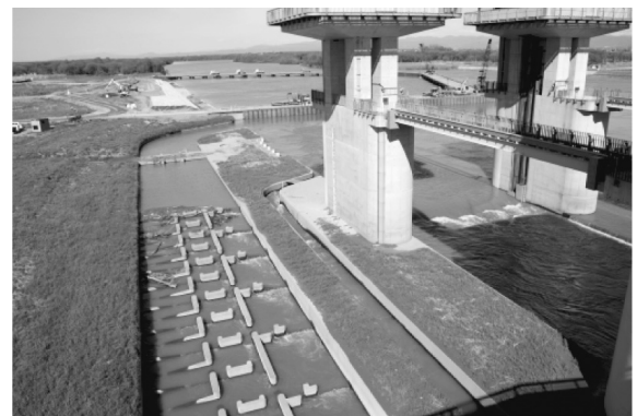
写真-2 右岸魚道、呼び水水路、土砂吐ゲート
