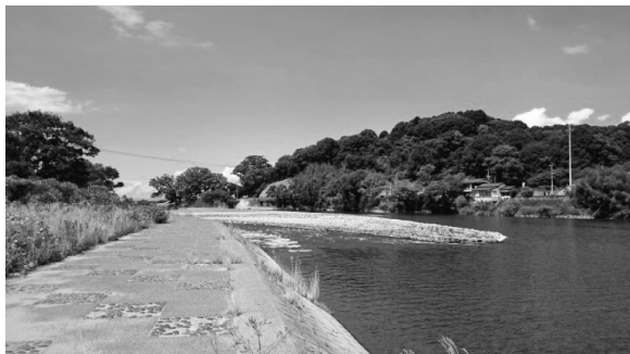
写真-1 上流部から撮影した山田堰（河川に対して斜め方向に設計されており、本流（左岸側）と取水口（右岸側）に分水されるような形になっている）
