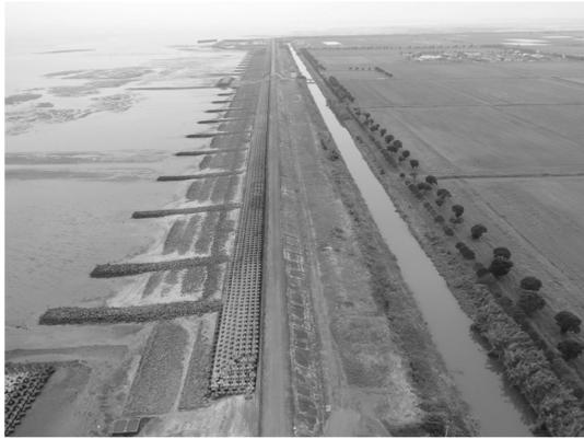
写真-2 海岸堤防の改修状況 (生物多様性の確保)
