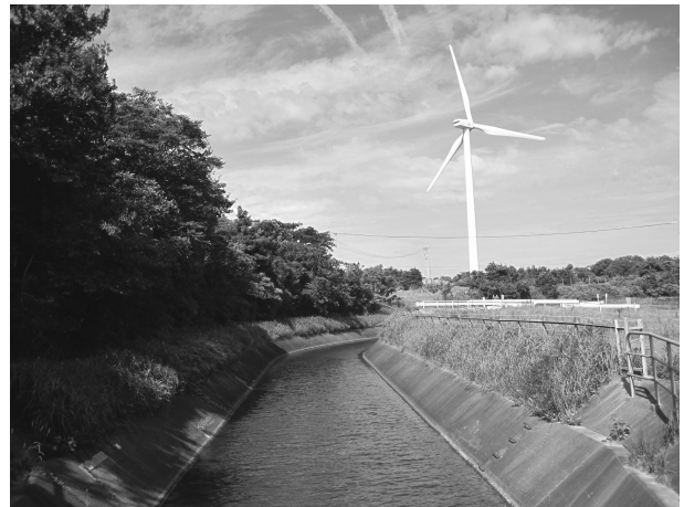
写真-1 東部幹線水路
