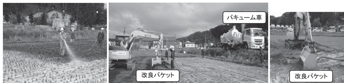
図 3 固化剤を用いた剥ぎ取り工法の各工程（吹き付け→乾燥→削り取り→収集、図 1、B 圃場）
