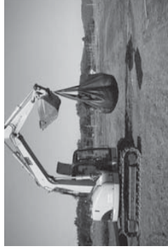
3) 固液分離(上澄み液排水) 4) 乾燥後の排出(1.73m 3 /4.2a) (総研社、2011.8)
