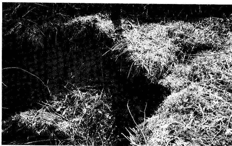
写真－１ 崩壊現場の例
