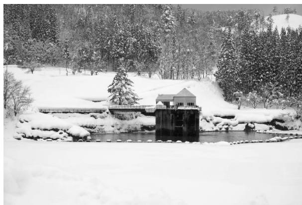
写真-4 雪景色の中の皆瀬ダム取水塔（平成28年1月21日撮影）
