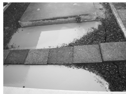
写真-3 地割れと液状化現象
