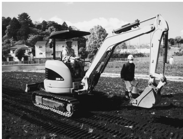
写真-5 小型車両系建設機械
