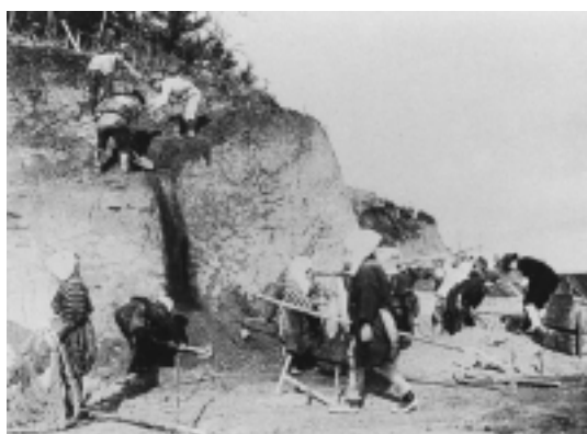
写真2 復旧作業状況
