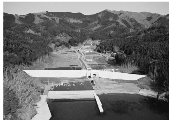
写真-2 大船渡市合足地区・海岸保全施設 （上：被災直後，下：完成後平成28年3月）
