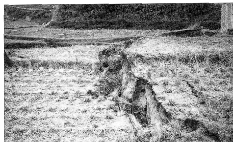
写真-⑥ クラック状況
