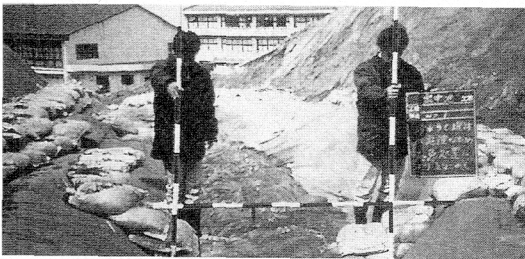
③堤体開削断面
