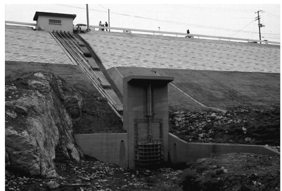
写真-2 堤体と斜樋、土砂吐ゲート（平成 15 年）
