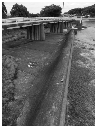
写真-3 余水吐（手前から固定堰、向こう側が自動堰）
