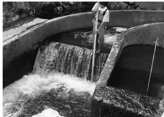
写真-1 上り口の段差の状況
