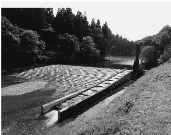
写真-2 整備された大畑頭首工魚道
