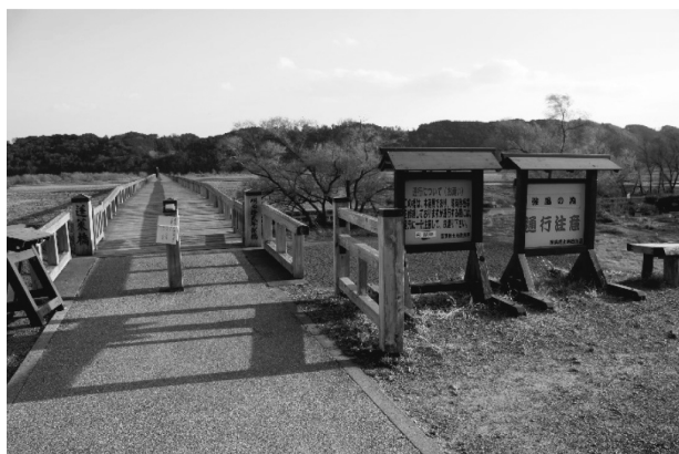
写真-1 大井川左岸からの蓬萊橋（右に屋根付き看板、車止めには通行料の案内札がある。）
