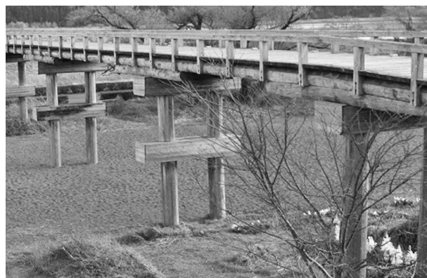
写真-2 橋の構造（床板と桁木）
