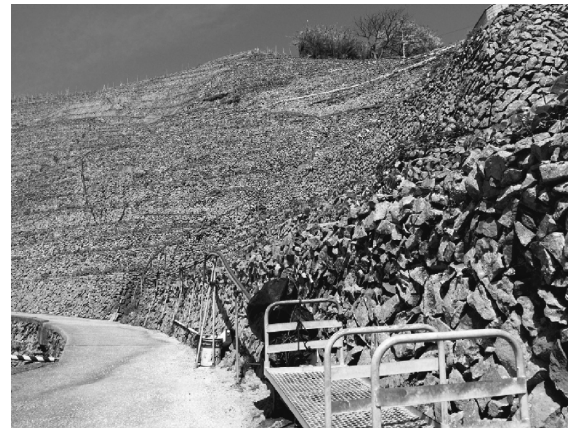
写真-3 運搬作業用モノレールと石垣
