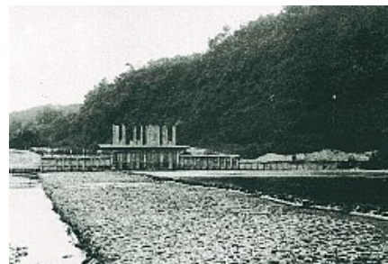
写真2 明治42年まで使用していた木造樋門
