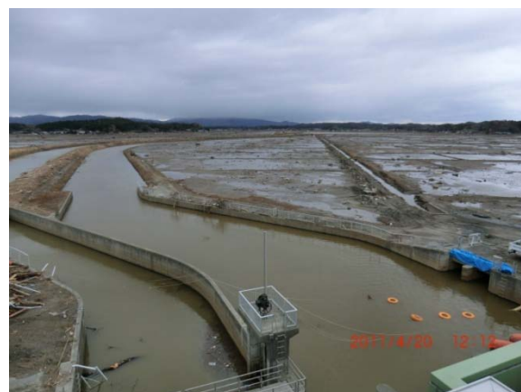
図 9 4 月 20 日の湛水状況
