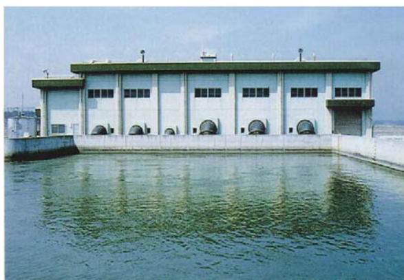
図5 八沢排水機場（正面、被災前）
