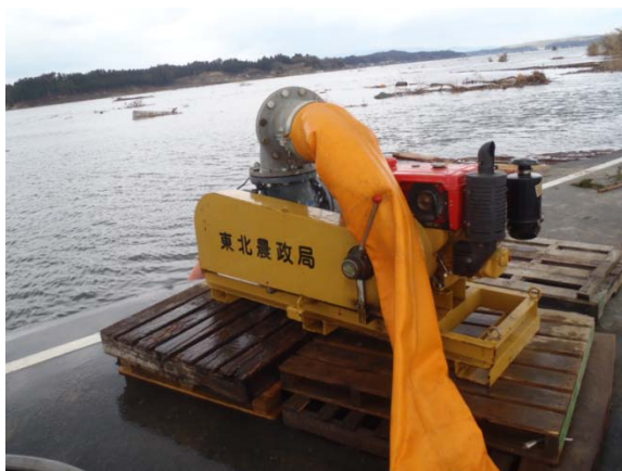
図 8 農政局による災害応急用ポンプ強制排水 (3 月 23 日福島県撮影)
