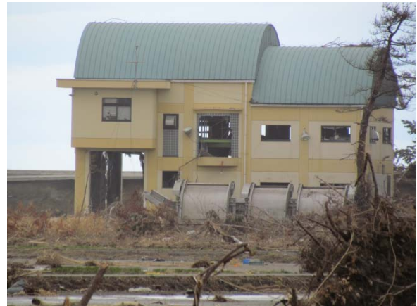
図 14 古磯部第 2 排水機場
