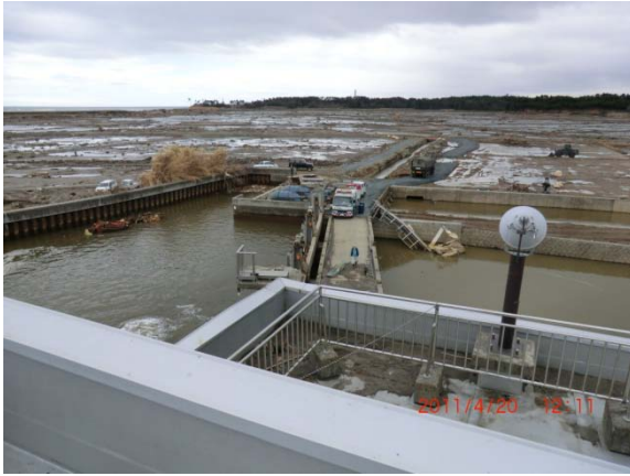
図 10 防潮樋門破損への対応（国交省ポンプ車による強制排水）（4 月 20 日）
