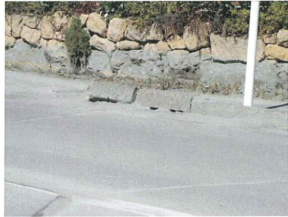
液状化で噴出した砂の跡(日の出、石垣に 20 ~ 30cm の痕跡が残っていた)
