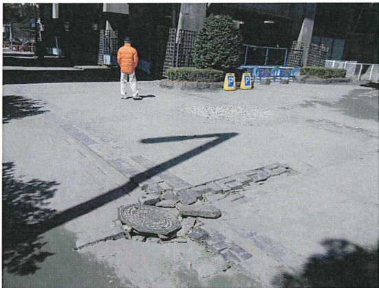
液状化で吹き上がった砂に覆われる歩道とマンホールの破壊状況（京葉線ガード南）
