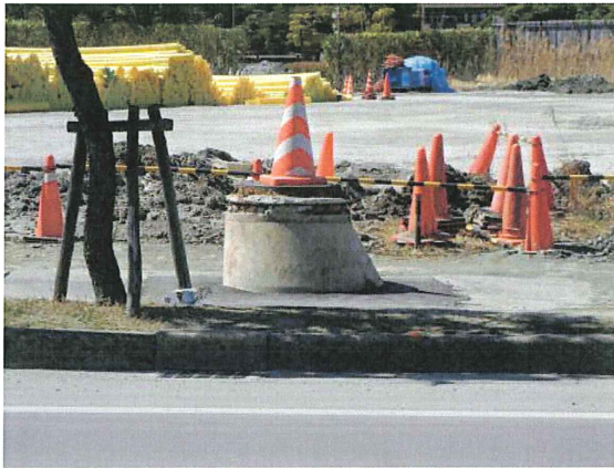
液状化で 70cm ほど浮き上がったマンホール (日の出、この区間で最大のもの)
