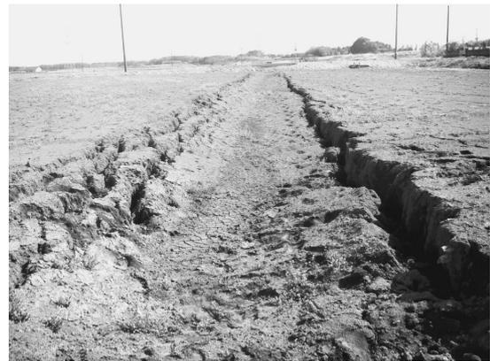
写真-1 液状化によるパイプライン埋戻し土の陥没状況
