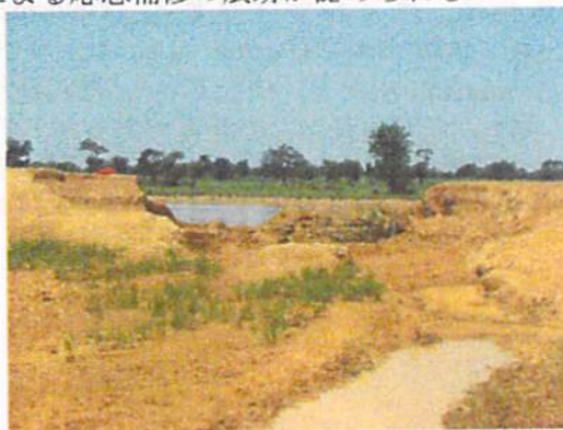
写真3：ダム4決壊個所の状況(2009/10/10現在)
