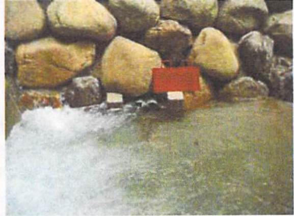
写真-2 側方取水用パイプ
