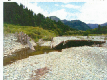
Fig.2 長尾の築 右岸側下流から魚取部を撮影：砂礫で埋没
