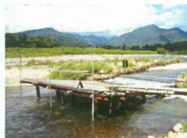
Fig.1 大谷の築 (A:魚取部、B:堰部)
