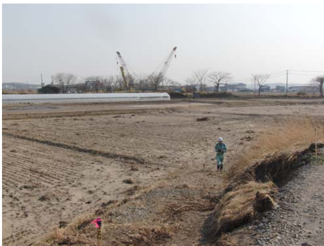
五戸川右岸 水田といちご畑の冠水被災（右：津波が河川堤防を越流し左の水田と畑に流入した）
