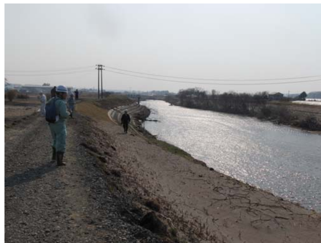
五戸川右岸 水田といちご畑の冠水被災（右：津波が河川堤防を越流し左の水田と畑に流入した）
