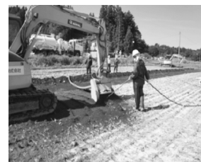
バキュームによる土壌の吸引
