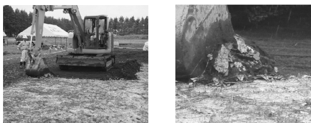
アームを水平に移動させ、表層土壌を筋状に集積
