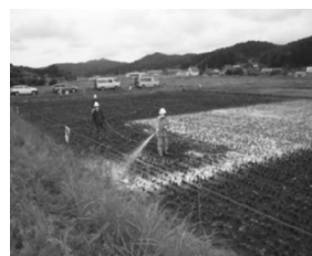
固化剤の散布作業
