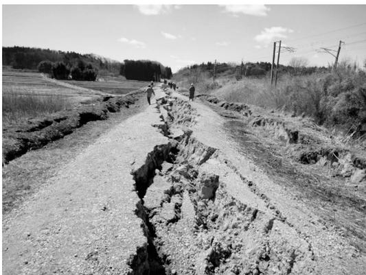
写真-1 パイプの浮上による被害状況
