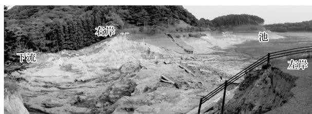
写真-2 藤沼湖の堤体崩壊状況
