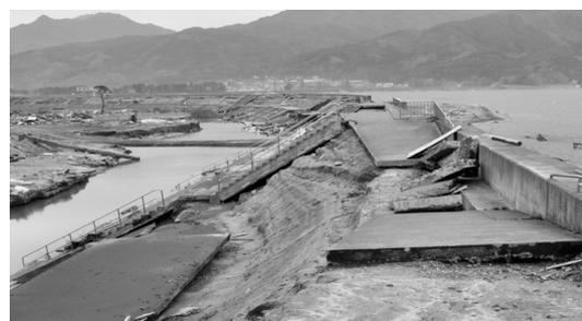
写真-3 津波越流を受けた堤防の被災
