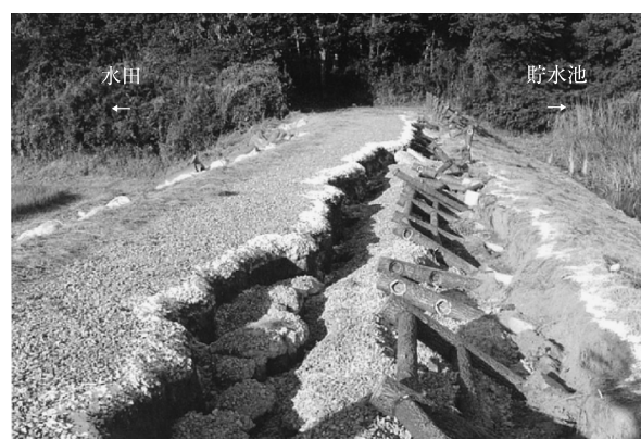
写真-1 宮城県北部連続地震による A ため池の堤体崩壊
