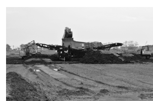
写真-2 振動式スクリーンに よる小がれきの除去
