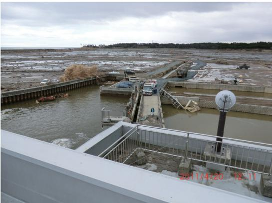
写真-3 防潮樋門破損への対応（国交省ポンプ車による強制排水）
