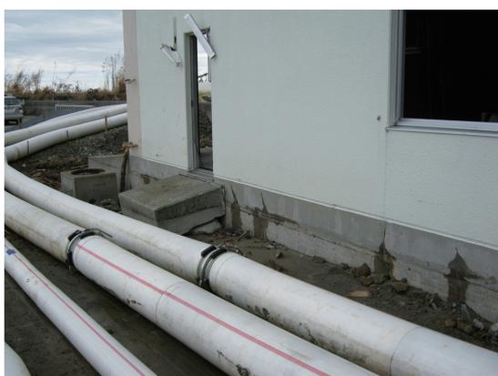
写真-12 排水機場の抜け上がり
