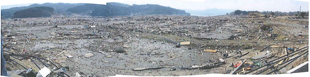
写真-5 小崎下ため池の西約100 m。北側を望む。一部に稲株が見えるが大部分は瓦礫で覆われている。
