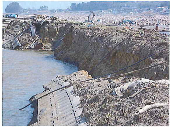
写真-4 小崎下ため池。池の外上部に漁船。ため池の内法が大きく侵食。堤体の一部が欠損し（高さ約2 m，幅約3 m），水位が低下。
