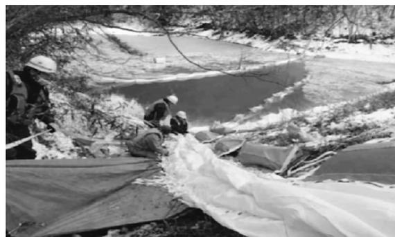
写真-2 シルトフェンス設置状況
