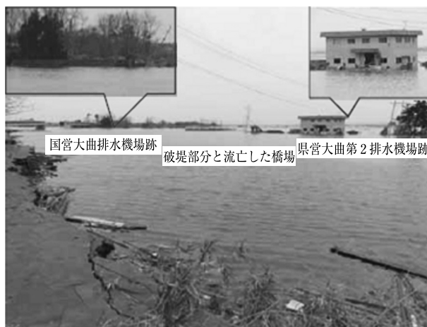
写真-1 石巻市周辺の排水機場の被害状況 2)
