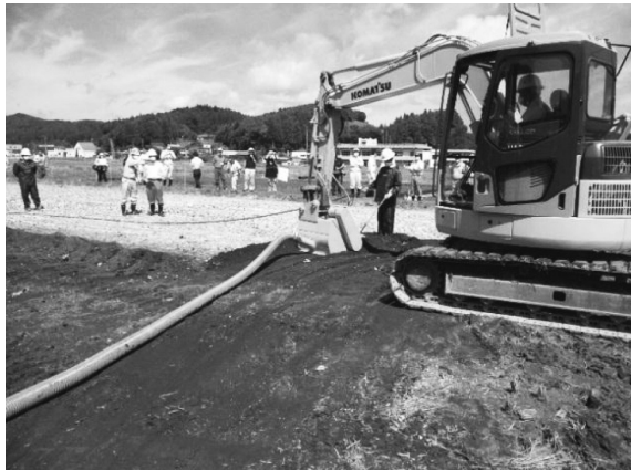
写真-5 農地土壌の除染のための表層土の削り取り状況 7)
