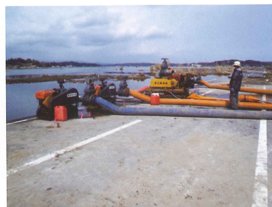
写真-8 農地の応急排水作業 (南相馬市)
