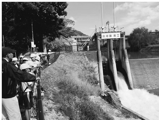
写真-2 淡河川頭首工
